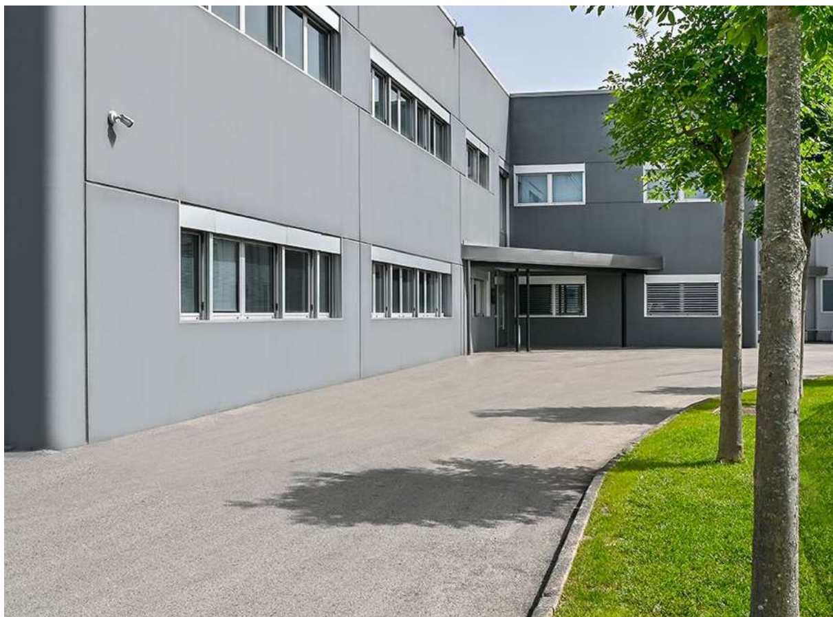
Stabilimento via Mattei, Serra de' Conti
