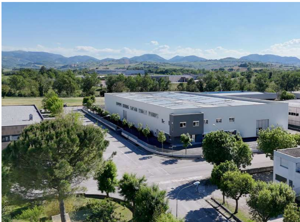
Stabilimento via Vanoni, Serra de' Conti
