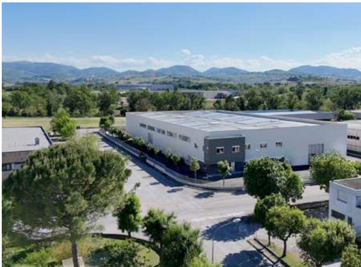
Stabilimento via Vanoni, Serra de' Conti
